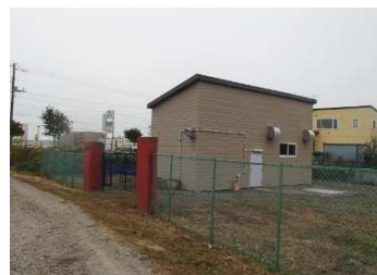
港ポンプ場 (雨水)
