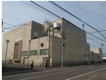
大手ポンプ場 (雨水)
