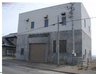
志海苔ポンプ場 (汚水)
