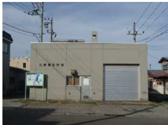
住吉ポンプ場 (汚水・雨水)
