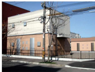
東雲町変電所
