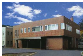
赤川高区浄水場
