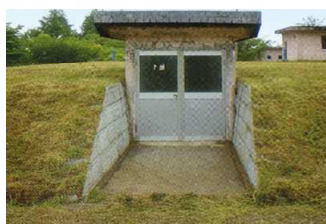
尾札部浄水場
