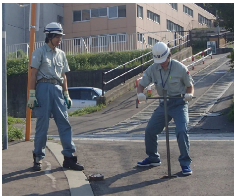
断水作業仕切弁操作訓練
