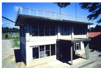
赤川低区浄水場
