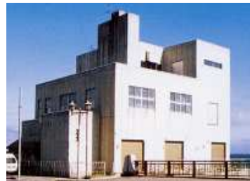
宇賀浦中継ポンプ場 (汚水)
