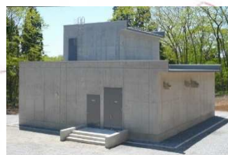
日ノ浜浄水場
