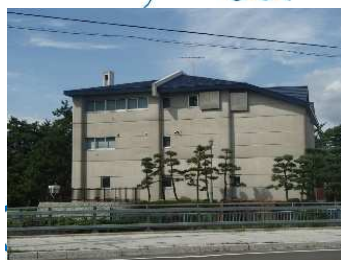
湯川ポンプ場 (汚水)
