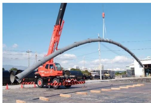
耐震継手の水道管
