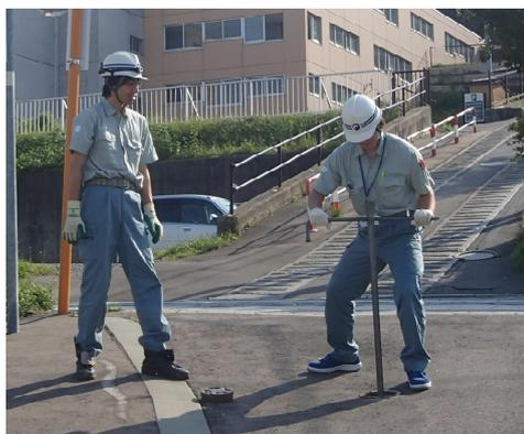
断水作業仕切弁操作訓練
