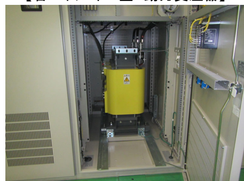
【省エネルギー型 動力変圧器】
