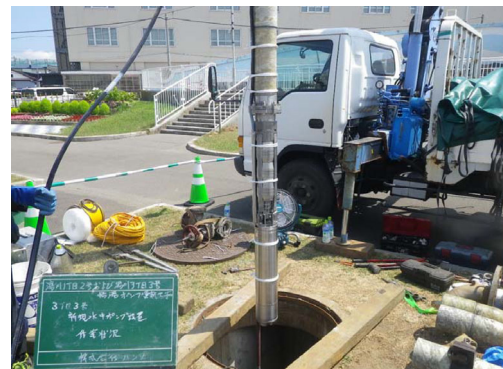
【湯川3丁目3号 揚湯ポンプ更新工事】
