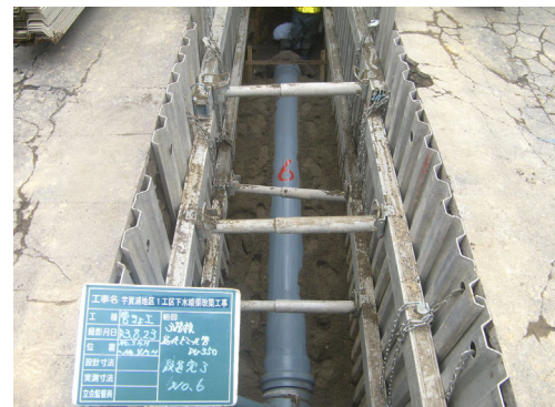
【宇賀浦地区 下水暗渠改築工事】
