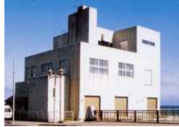
宇賀浦中継ポンプ場 (汚水)
