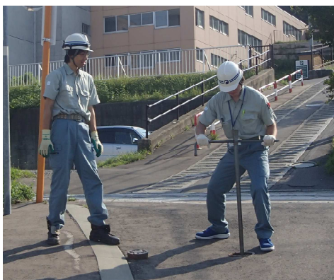
断水作業仕切弁操作訓練
