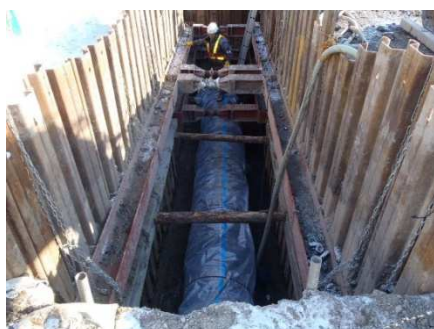
配水管布設工事
