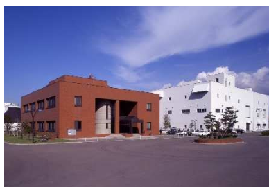
函館湾浄化センター管理棟
