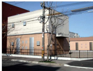
東雲町変電所
