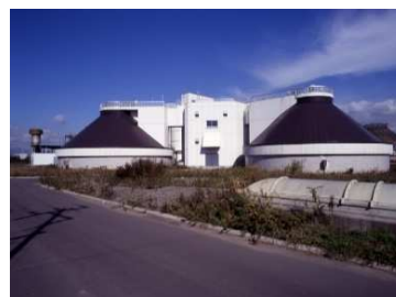
函館湾浄化センター汚泥処理施設
