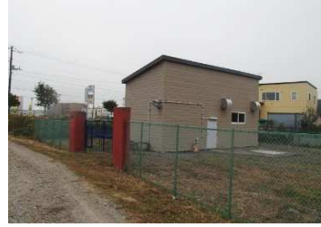
港ポンプ場 (雨水)
