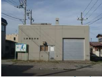
住吉ポンプ場 (汚水・雨水)
