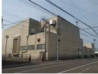
大手ポンプ場 (雨水)
