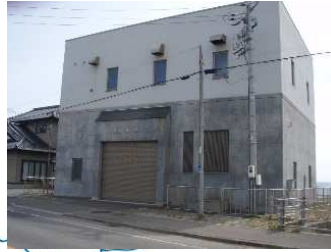
志海苔ポンプ場 (汚水)
