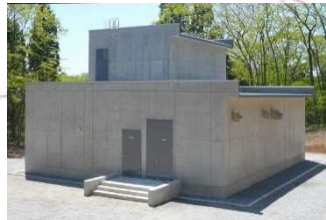
日ノ浜浄水場
