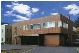
赤川高区浄水場
