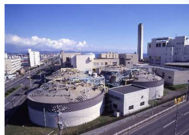
南部下水終末処理場 汚泥処理施設
