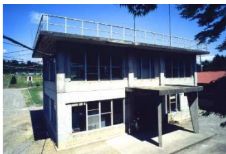
赤川低区浄水場
