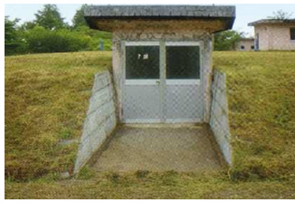
尾札部浄水場
