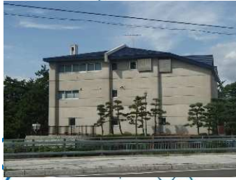
湯川ポンプ場 (汚水)
