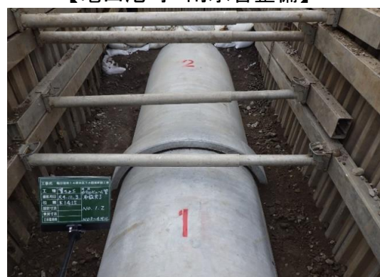
【亀田港町 雨水管整備】
