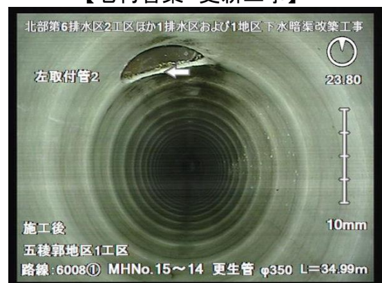
【老朽管渠 更新工事】
