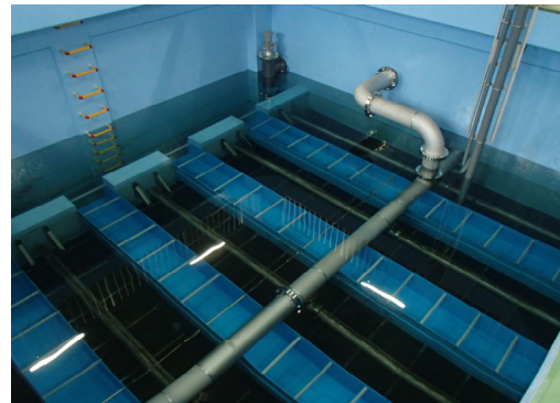
【赤川高区浄水場ろ過施設更新工事】
