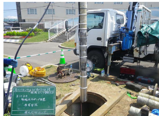
【湯川3丁目3号 揚湯ポンプ更新工事】
