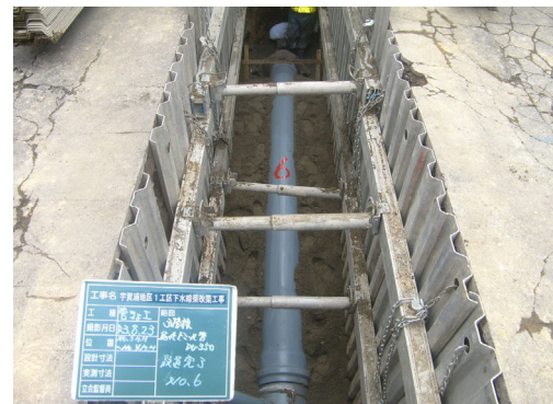
【宇賀浦地区 下水暗渠改築工事】
