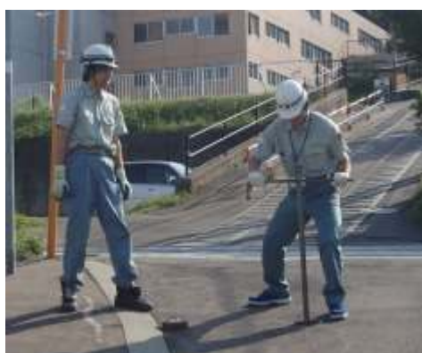
断水作業仕切弁操作訓練
