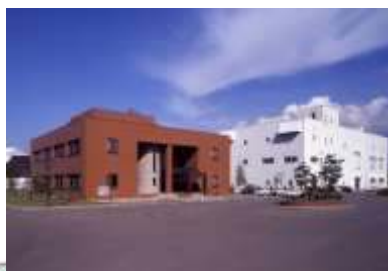
函館湾浄化センター管理棟
