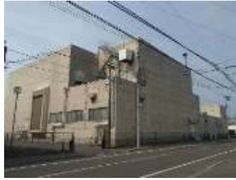
大手ポンプ場 (雨水)
