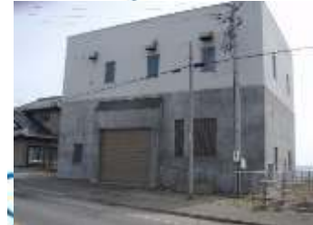
志海苔ポンプ場 (汚水)
