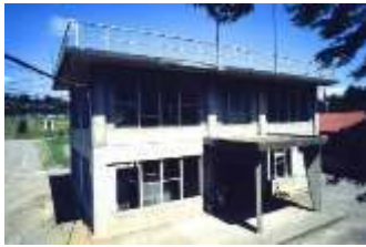
赤川低区浄水場
