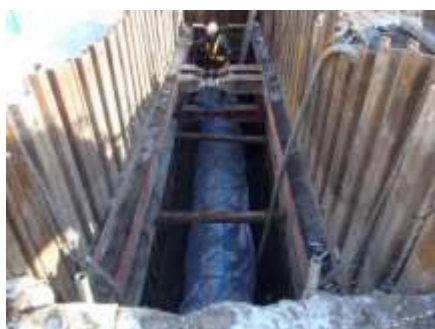
配水管布設工事
