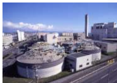
南部下水処理場 汚泥処理施設
