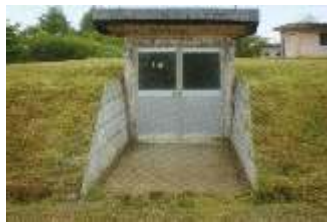
尾札部浄水場
