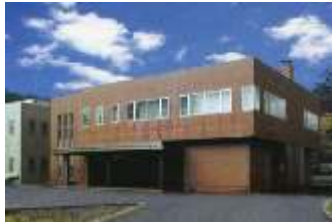
赤川高区浄水場
