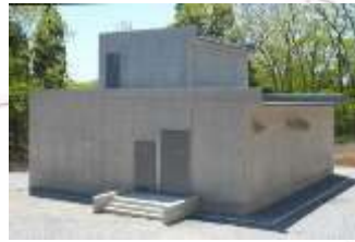
日ノ浜浄水場
