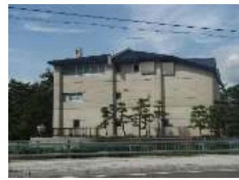
湯川ポンプ場 (汚水)
