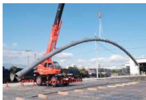
耐震継手の水道管
