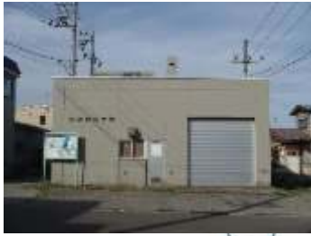
住吉ポンプ場 (汚水・雨水)
