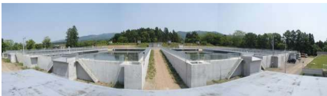
更新後の赤川低区浄水場 2 系緩速ろ過池
