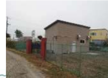
港ポンプ場 (雨水)
