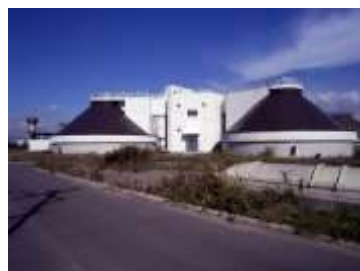
函館湾浄化センター汚泥処理施設
