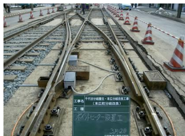
分岐器を千代台から移設し、ポイントヒーター(凍結防止ヒーター)を設置している状態
