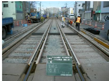
撤去し、コンクリート施工する前の状態
