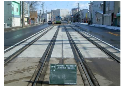
施工後・コンクリート道床と隙間のゴムパッキン化
