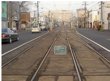
施行前・分岐器および軌道の状態
