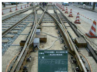
分岐器を千代台から移設し、ポイントヒーター（凍結防止ヒーター）を設置している状態
