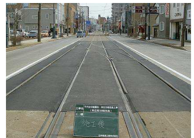
施工後・見た目はあまり変化無いが、レール状態などは良好
