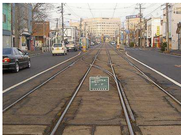
施行前・分岐器および軌道の状態
