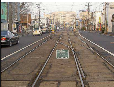
施行前・分岐器および軌道の状態
