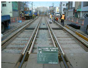
撤去し、コンクリート施工する前の状態
