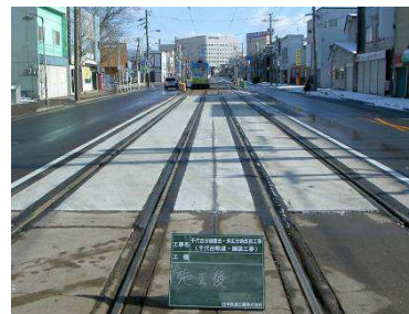
施工後・コンクリート道床と隙間のゴムパッキン化
